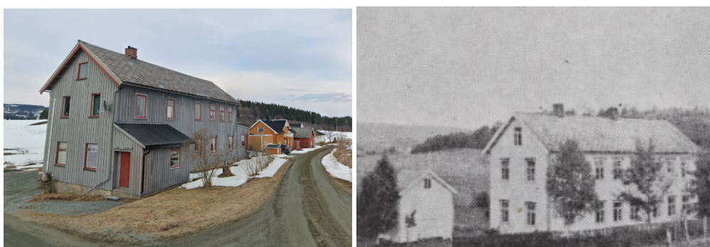
Figur 15 Breidablikk gamle skole sett fra vest mot nord, t.v. i 2023 og t.h. på 1950/60-tallet. Kilde: Google Street view og t.h. Norges bebyggelse.
